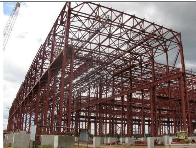
Рис. 1.4. Пример типового промышленного здания с применением металлокаркаса
