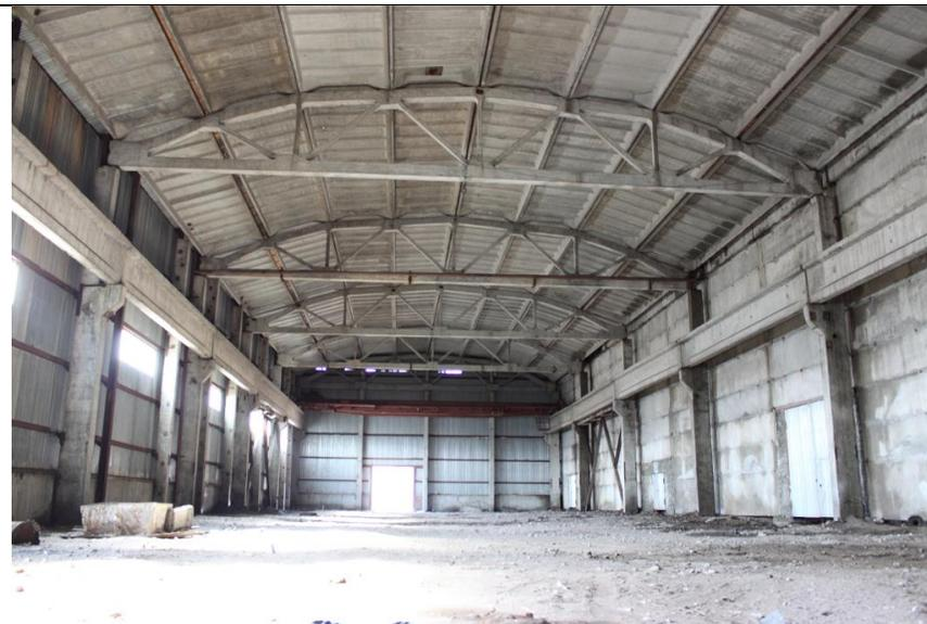
Рис.1.2. Пример типового панельного промышленного здания
