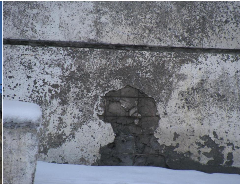
Фото 10. Разрушение железобетонной самонесущей панели здания котельной. Оголение и коррозия арматуры
