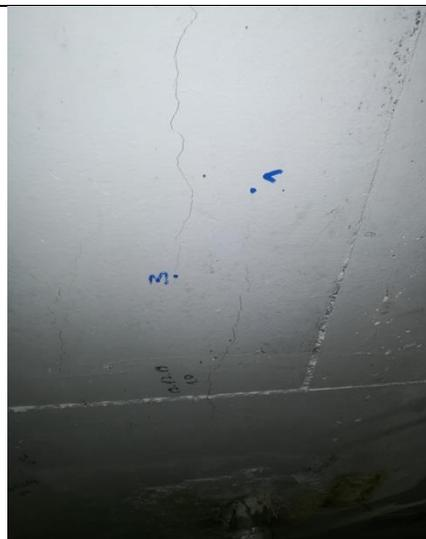
Фото 6. Поперечные трещины длиной до 120 см и шириной раскрытия до 1 мм на плите перекрытия технического подполья здания в осях Гс-Дс/3с-5с
