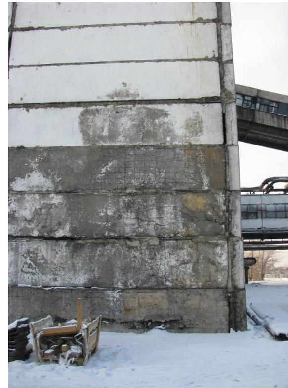
Фото 12. Разрушение железобетонной самонесущей панели здания котельной. Оголение и коррозия арматуры
