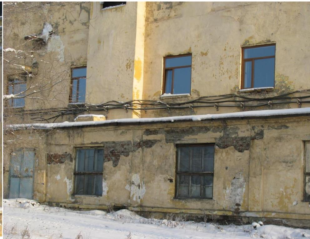
Фото 8. Разрушение штукатурного слоя и кирпичной кладки несущей стены здания турбинного зала
