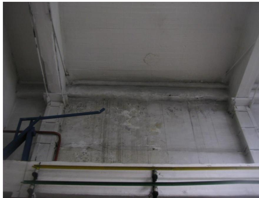
Фото 14. Разрушение подкрановой балки и намокание штукатурного слоя несущей стены турбинного зала
