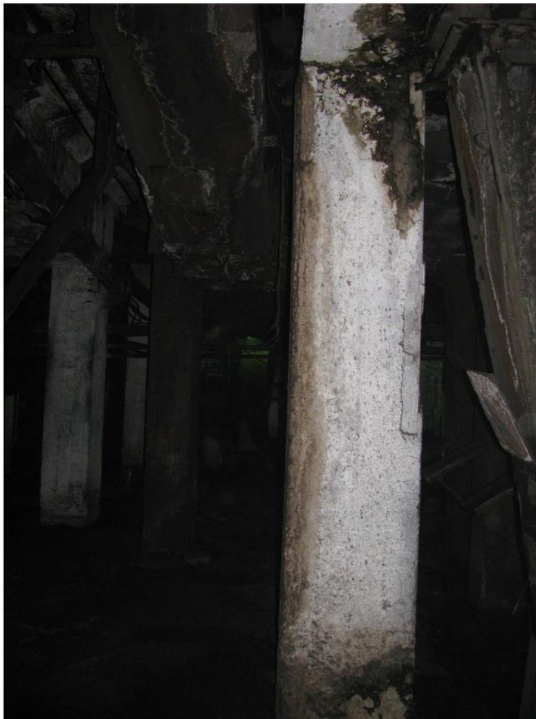
Фото 19. Разрушение защитного слоя бетона, оголение и коррозия арматуры железобетонных колонн
