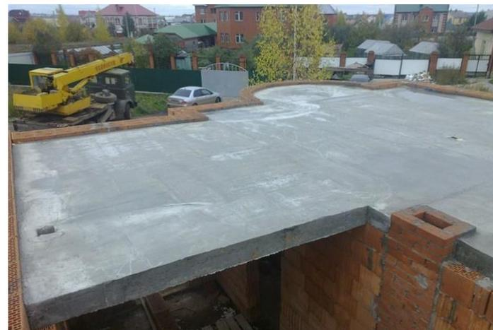
Рисунок 4 – Монолитные железобетонные плиты
