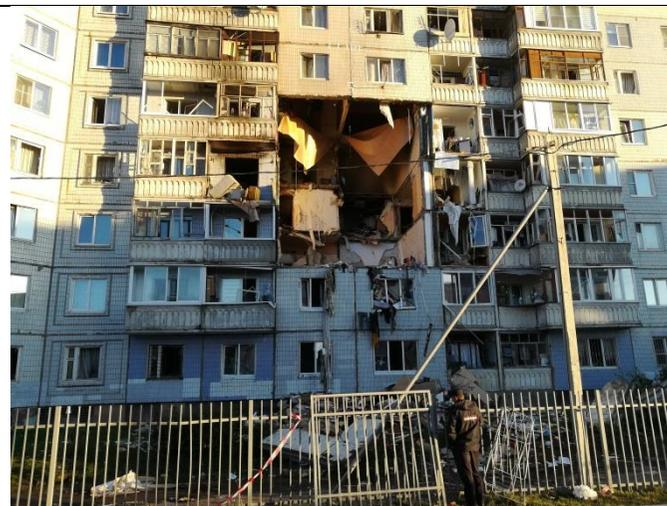
Фото 10. Общий вид повреждений с 3 по 5 этажи на фасаде панельного здания
