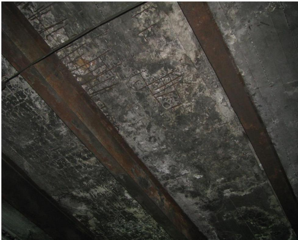
Фото 17. Оголение и коррозия арматуры плит перекрытия
