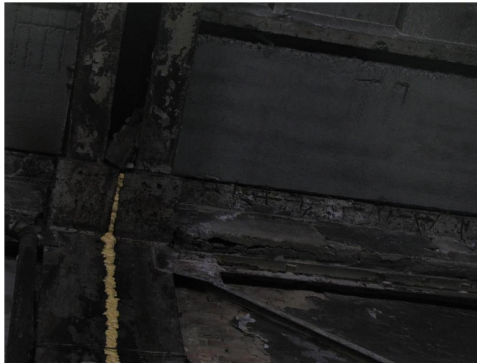
Фото 16. Разрушение защитного слоя железобетонных конструкций, оголения и коррозия металлических конструкций турбинного зала
