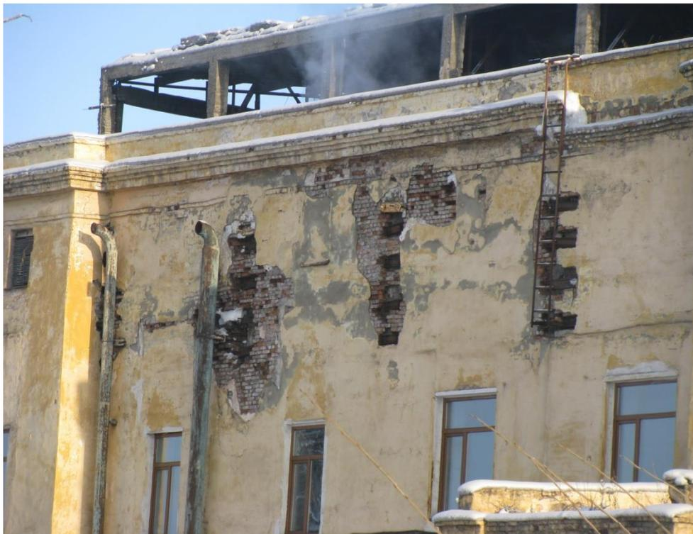
Фото 7. Разрушение штукатурного слоя и кирпичной кладки несущей стены здания турбинного зала
