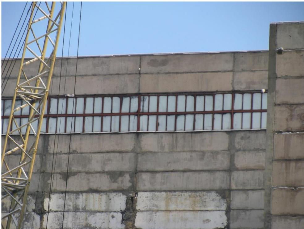
Фото 5. Разрушение железобетонных самонесущих навесных панелей здания котельной
