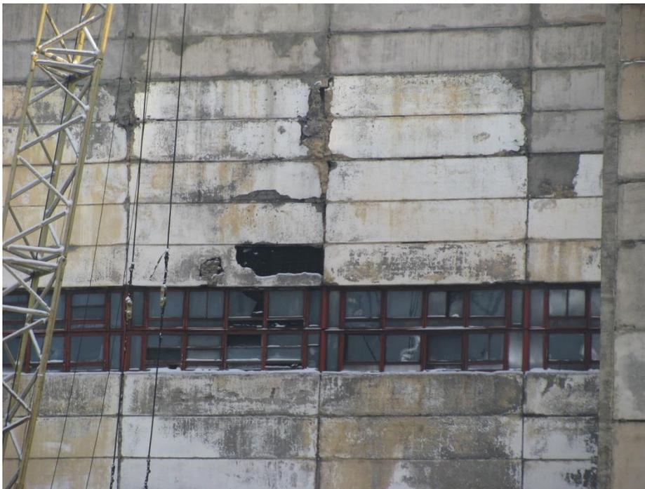
Фото 3. Разрушение железобетонной самонесущей навесной панели здания котельной
