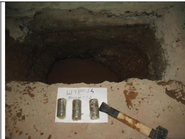
Фото 8. Фотоиллюстрация мест вскрытия фундаментов шурф №4
