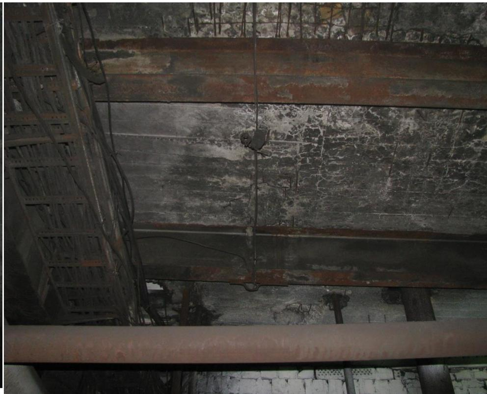
Фото 18. Оголение и коррозия арматуры плит перекрытия между, коррозия металлических балок
