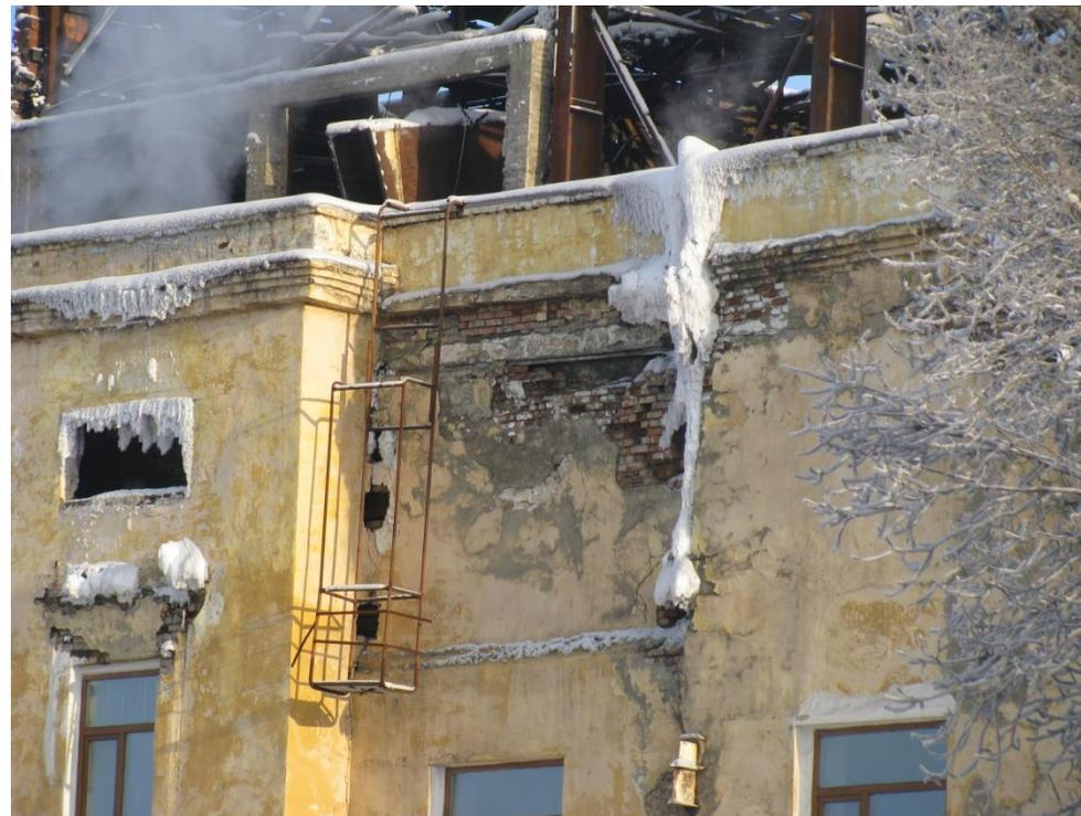
Фото 6. Разрушение штукатурного слоя и кирпичной кладки несущей стены здания турбинного зала
