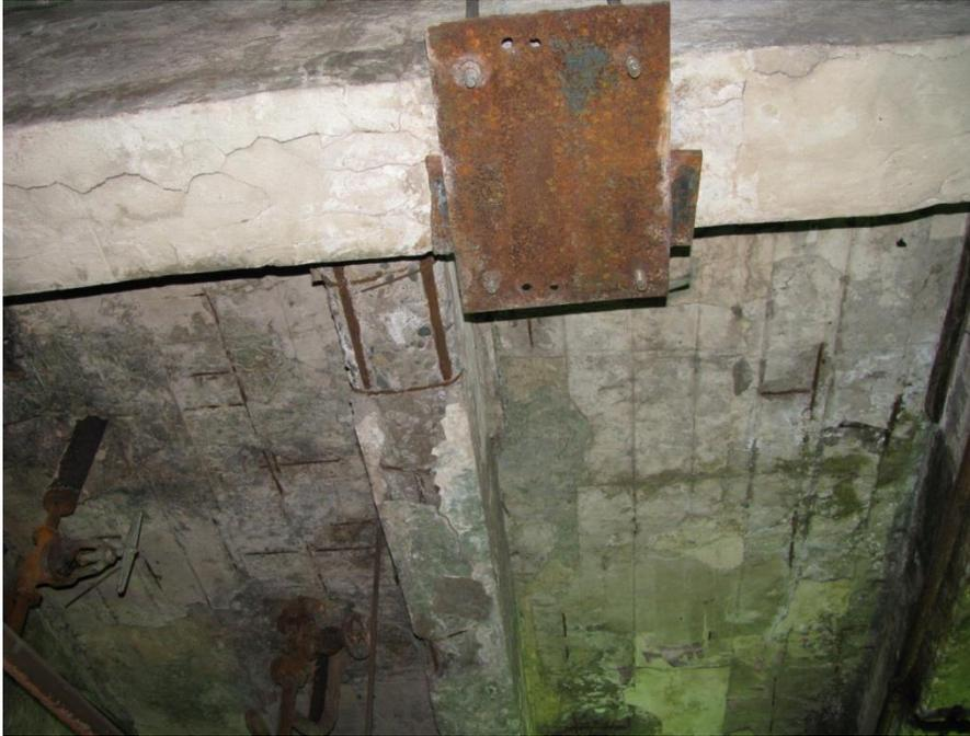
Фото 21. Разрушение защитного слоя бетона железобетонных плит перекрытия и балок, повлекшее оголение и коррозию арматуры
