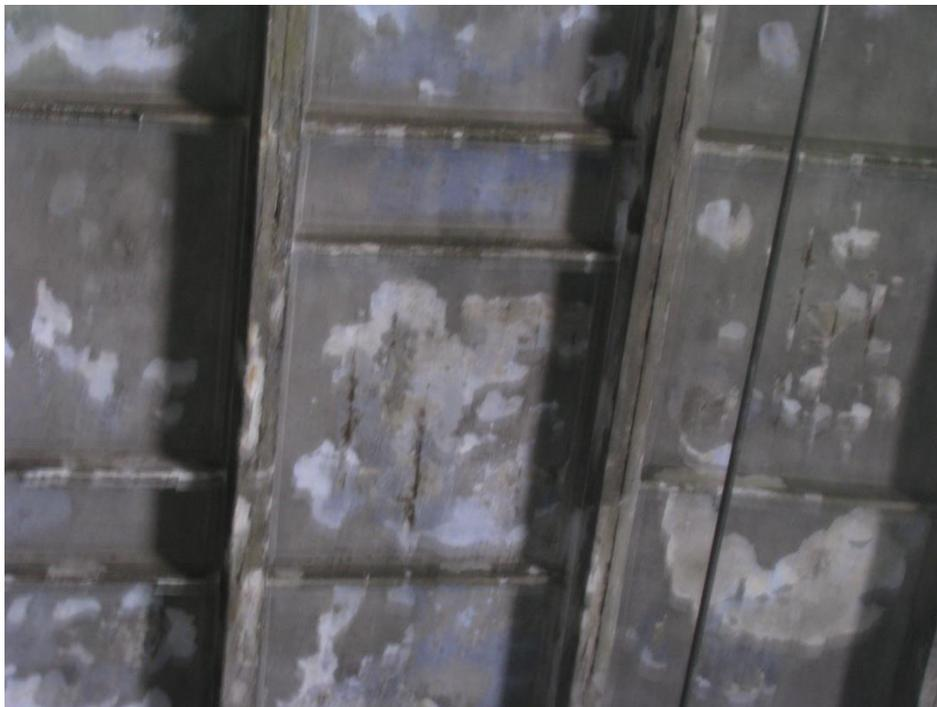
Фото 15. Разрушение защитного слоя, оголение и коррозия арматуры плиты перекрытия турбинного зала
