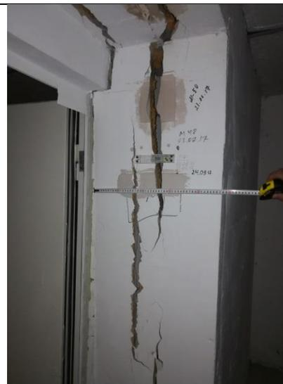
Фото 7. Раскрытие деформационного шва между секциями № 2 и № 3-4 и деформации строительных конструкций технического этажа здания в осях И-К/7с-8с (раскрытие шва составляет до 60 мм, но предположительно до 125мм, см. фото 18)
