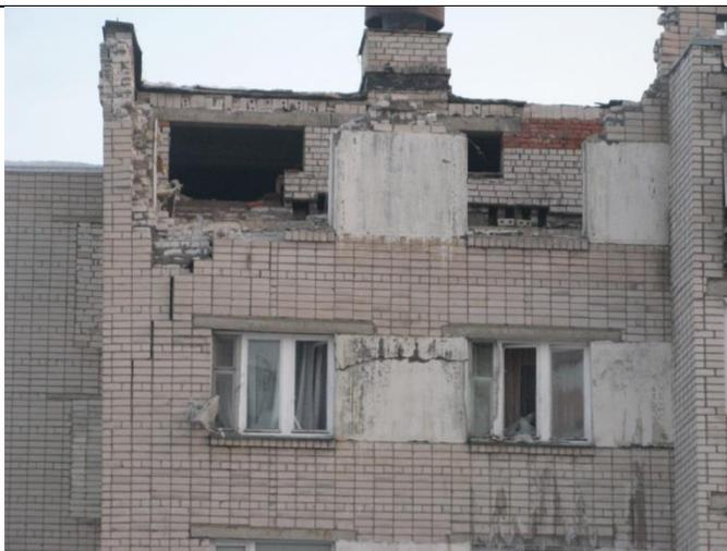
Фото 9. Общий вид поврежденных 4-5 этажей в осях А/11-12. Наклонная и вертикальная трещина на наружной стене кирпичного здания с 5 по 3 этажи
