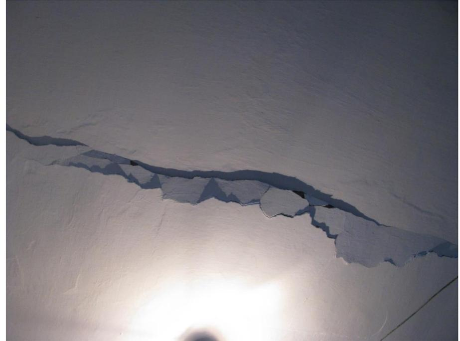
Фото 22. Сквозная трещина в плите перекрытия
