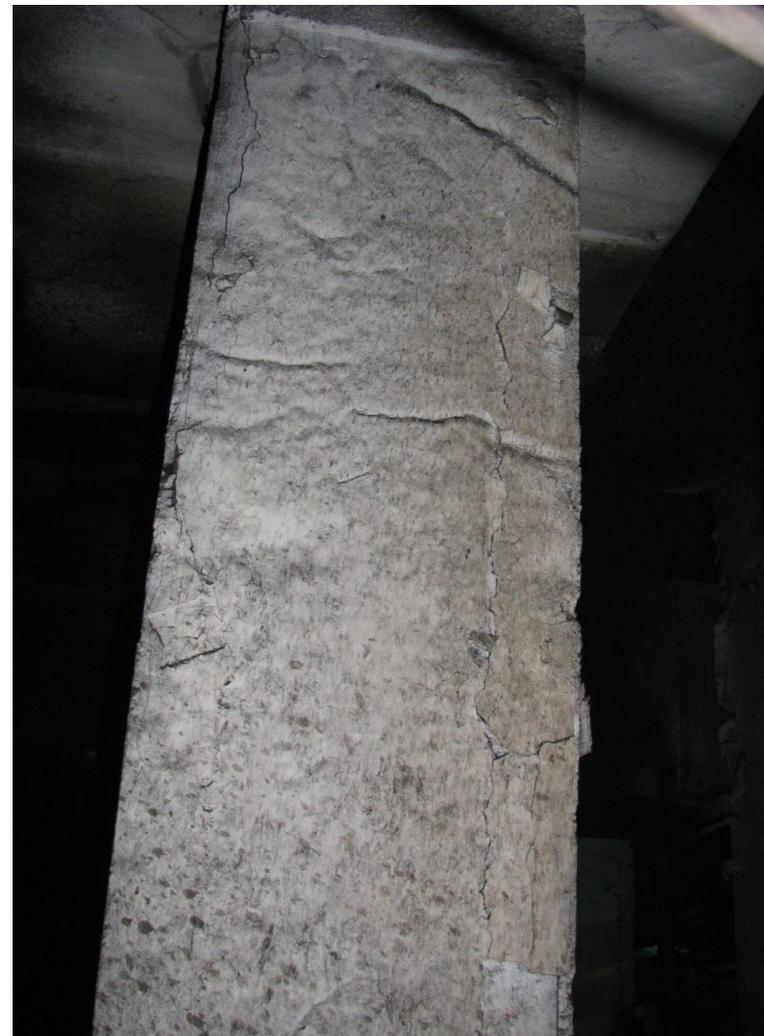
Фото 20. Вертикальная трещина в железобетонной колонне
