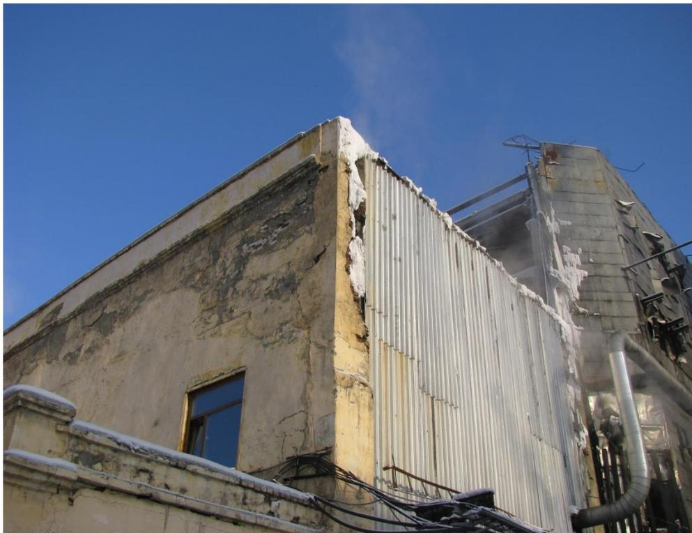
Фото 9. Вертикальная трещина в несущей стене здания турбинного зала
